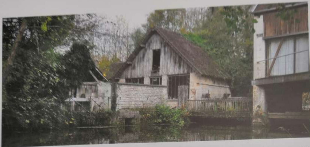
Le Moulin de Courteron (Aube) a été équipé en 2017 de trois vis d'Archimède pour une puissance totale de 135 kW, grâce à une collecte par Lumo de 350 000 € en obligations. Photo : Lumo
